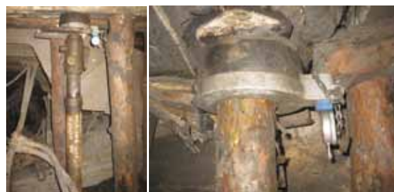
Рис. 8. Измерение нагрузки, действующей на охранное сооружение
