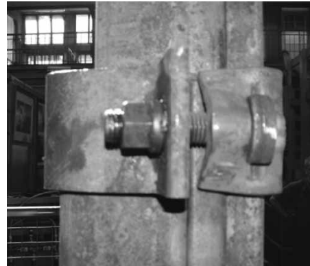
Рис. 5. Соединение двух профилей типа V с использованием замка типа SDO
