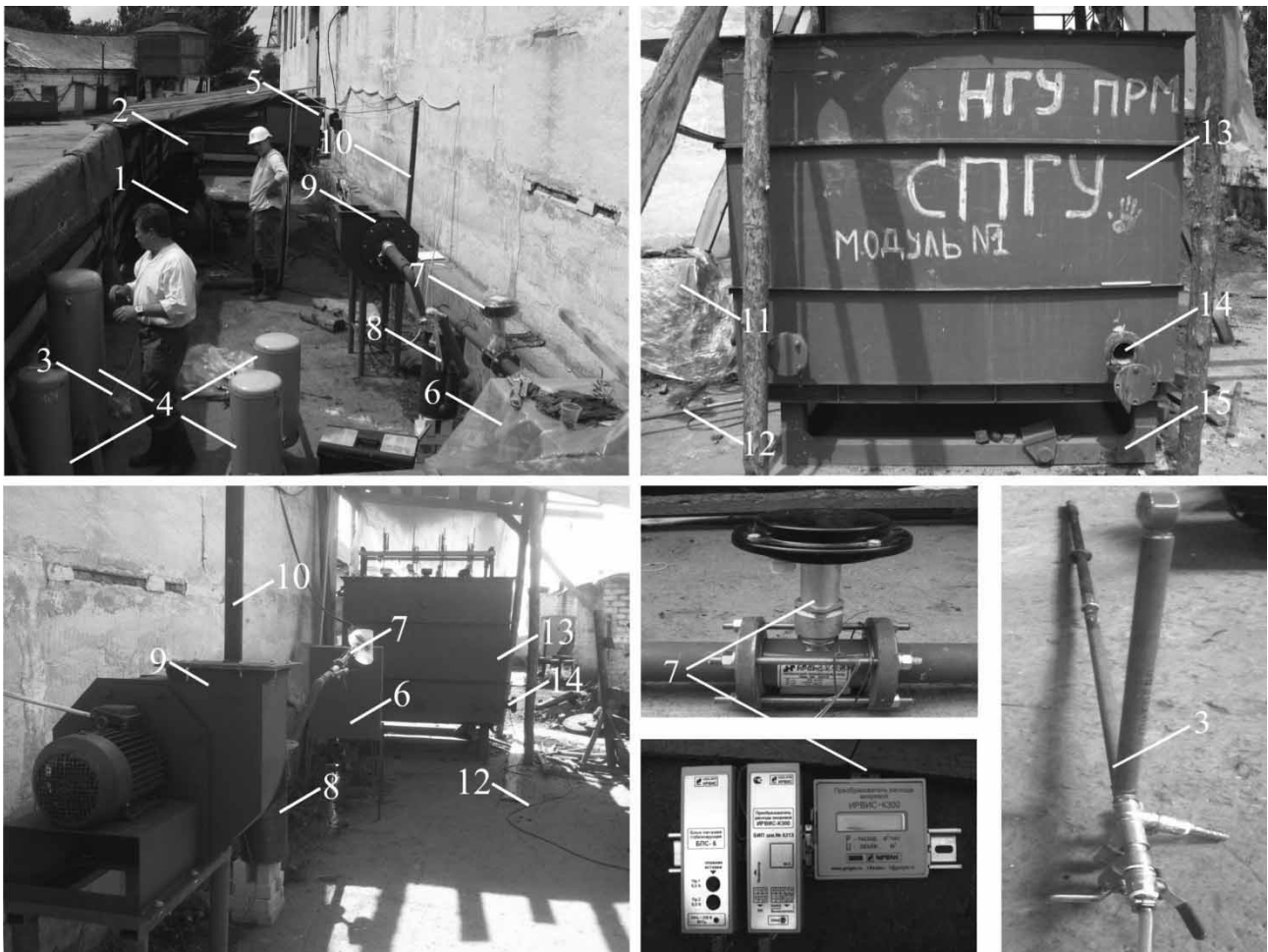
Рис. 1. Загальний вигляд і монтаж експлуатаційних систем стенду СПГВ: 1 – компресор РМ-3138; 2 – парогенератор АВРЕ-11/9; 3 – керуючий високонапірний трубопровід; 4 – ресивери (повітряний, паровий і кисневий); 5 – водний резервуар; 6 – бак-охолоджувач; 7 – витратомір ІРВІС-300С; 8 – вапняний фільтр (уловлювання H_2S ); 9 – димосос ДР-1,0-00.00ПС; 10 – димовідвід; 11 – бак збору роси і золоносів; 12 – керуючий гнучкий трубопровід; 13 – стендова установка; 14 – розпалювальна свердловина; 15 – платформа зміни кута нахилу стенду
