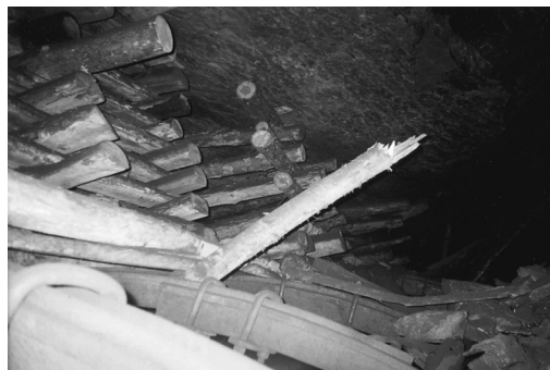
Рис. 3. Фрагмент вывала кровли восточного разведочно-дренажного штрека пласта пл. h_{10} гор. 880 м ОП Шахта „Комсомольская“ ГП „Антрацит“
