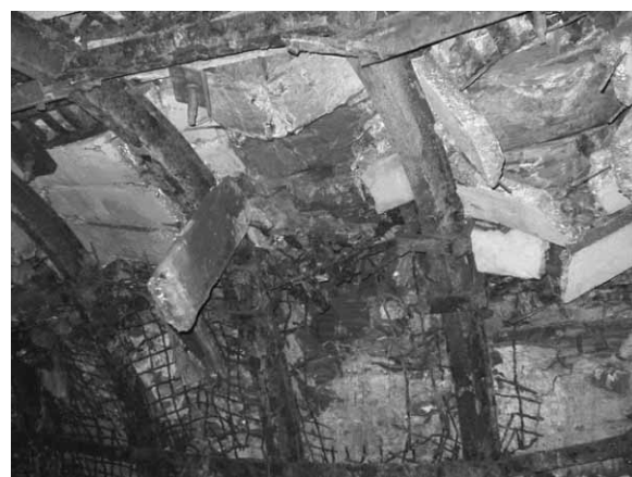
Рис. 3. Деформации рам арочной крепи
