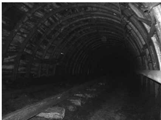
Рис. 2. Проявление дилатансии массива горных пород в почве выработок
