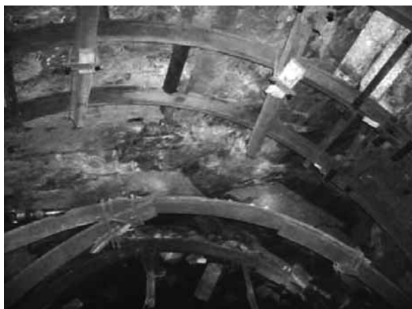
Рис. 6. Общий вид состояния кровли при невзрывном способе разрушения пород в сечении проектного контура выработки
