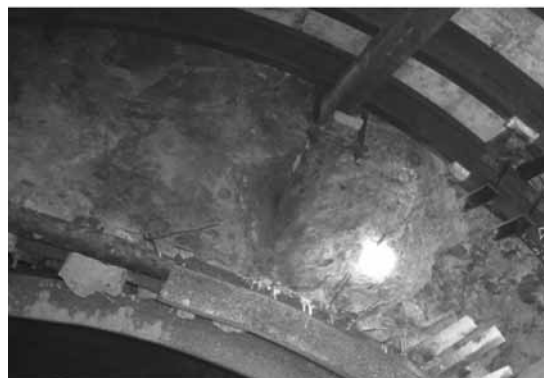
Рис. 2. Общий вид забоя перекрепления в западном магистральном откаточном квершлага гор. 493м
