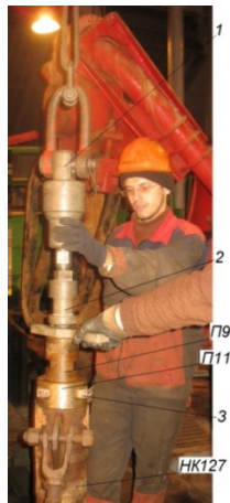
Рис. 5. Фрагмент наращивания защитной колонны ЗК-73
