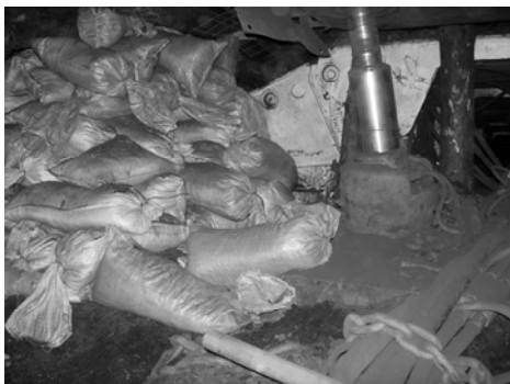
Рис. 5. Вид породной стенки после сооружения
