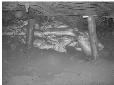
Рис. 6. Вид породной стенки на расстоянии 15 м от лавы
