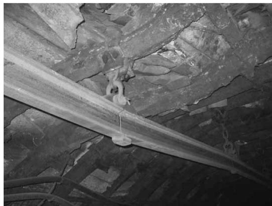
Рис. 1. Состояние крепи подготовительной выработки в зонах активного смещения пород кровли
